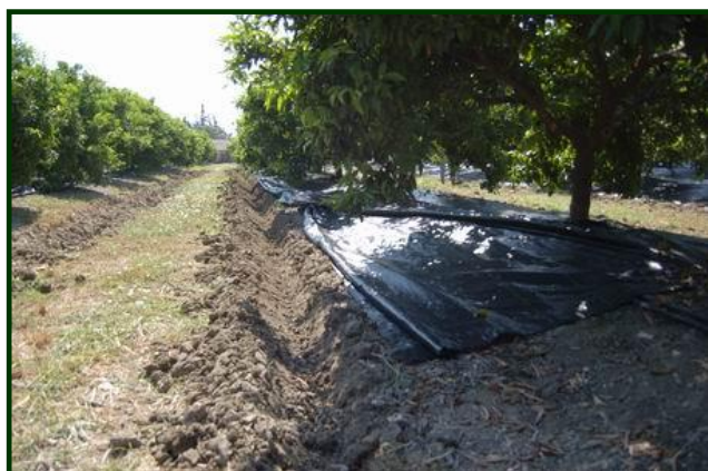
Instalación malla IFAPA Churriana
